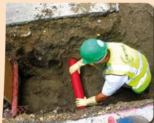
Mise en place d'une protection de ligne sous tension
