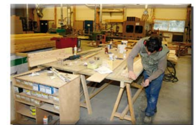
Fabrication, pose et utilisation de panneaux de bois
