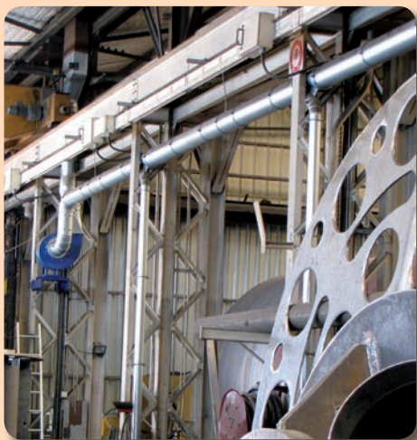
Un réseau de plus de 150 mètres de gaines, accessible depuis tous les capteurs de fumées permet d'évacuer les fumées à l'extérieur des ateliers.
