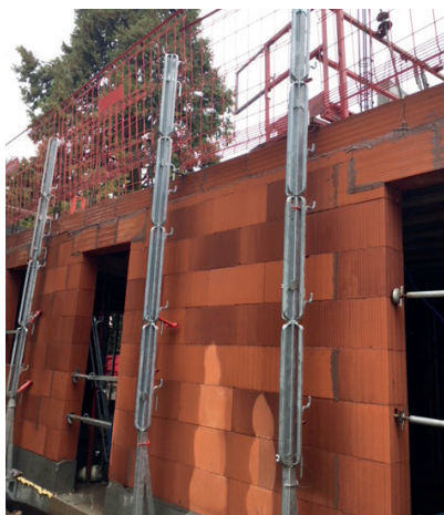
Les potelets s'empilent, supportant les garde-corps. (Photo © Carsat).
