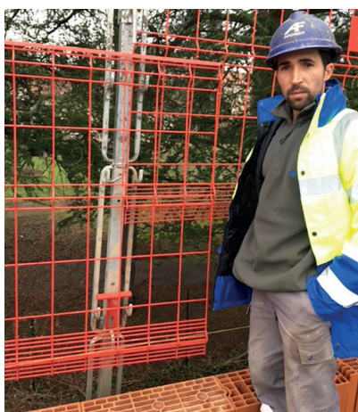
M. Nelson Martins chef de chantier, explique que les grilles garde-corps peuvent se relever pour monter le mur en brique en sécurité. (Photo © Carsat).
