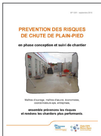
SP 1201 - Prévention des risques de chute de plain-pied
