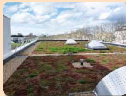
Toitures terrasses équipées de gardes corps et ouvertures des puits de lumière.
