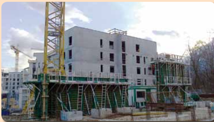
Chantier de logements Jean Monnet à Saint-Genis-Pouilly.
