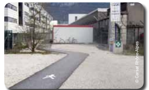
Accès chantier GSE : Chantier SCI BCC PRESQU'ILE/CREDIT AGRICOLE. La circulation des piétons est définie précisément et recouverte d'enrobé
