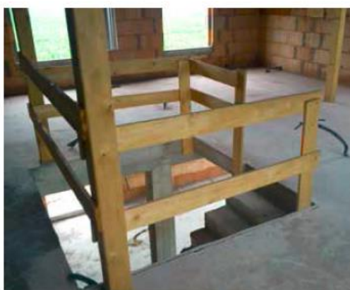
Escalier définitif avec garde-corps en bord de dalle
