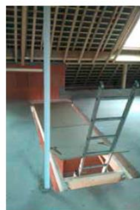
Mise en place d'une protection horizontale sur la trémie
