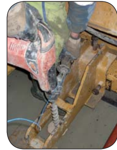
Perforateur Tunnel de la Bussière
