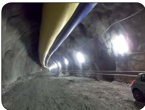
Galerie creusée - Tunnel de la Bussière
