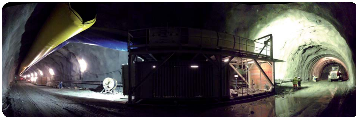
Ventilateur et front de taille - Tunnel de la Bussière
