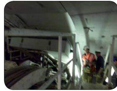
Pose de voussoirs - Tunnel de Gerland
