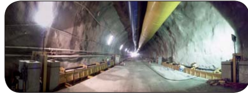
Galerie - Chantier banquettes Tunnel de la Bussière
