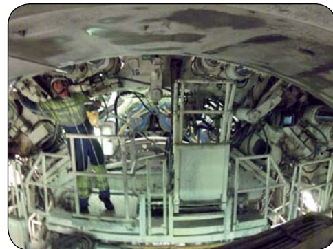
Pose des voussoirs passerelle supérieure Tunnel du Fréjus
