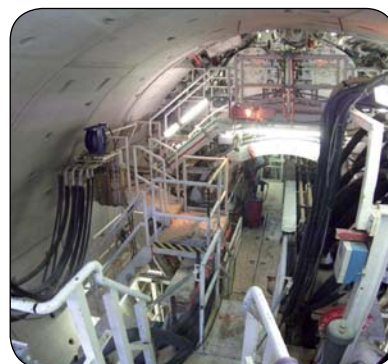
Pose des voussoirs - Tunnel de Gerland
