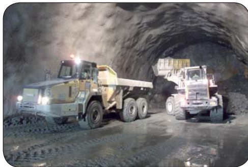
Marinage en front de taille - Tunnel de la Bussière
