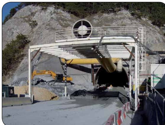
Entrée du tunnel de Fréjus
