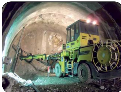
Foration pour mise en place explosifs au Robofore Tunnel de Chalosset
